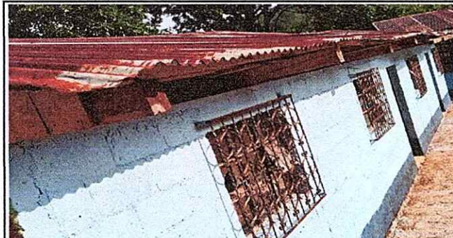
Foto 3: Las láminas cuentan con agujeros y las bigas tienen polilla módulo 3.
